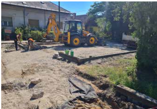
Gyógyszertár előtti parkoló építése
